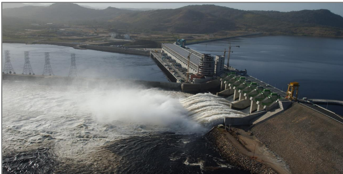
Imagen N° 7. Central Hidroeléctrica Francisco de Miranda (Caruachi)
