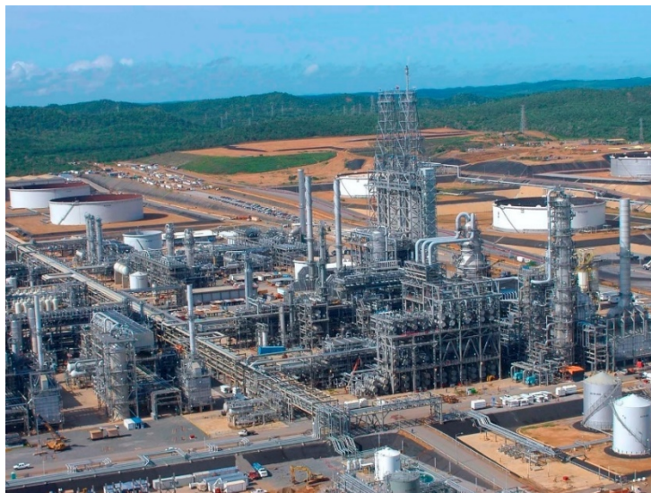
Proyecto Hamaca. Mejorador de crudo de Petropiar
