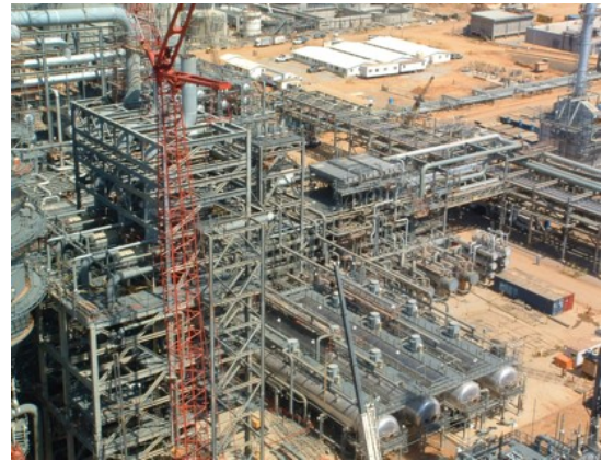
Estructura metálica, fabricada y montada por empresas venezolanas
