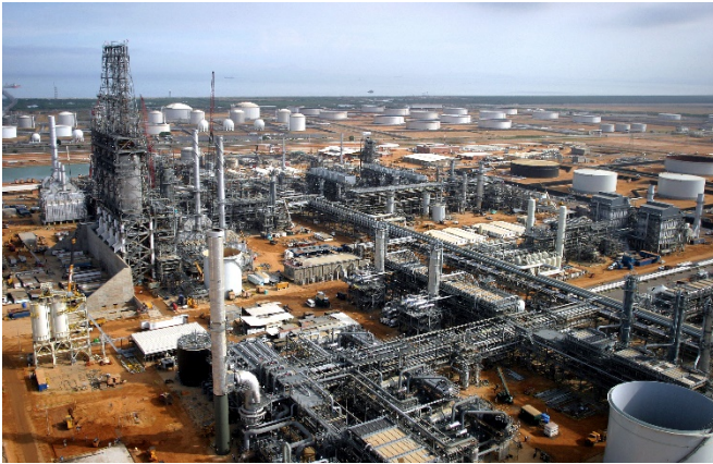
Construcción en Jose por empresas venezolanas
