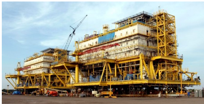
Plataformas construidas por empresa venezolana en México para el Golfo
