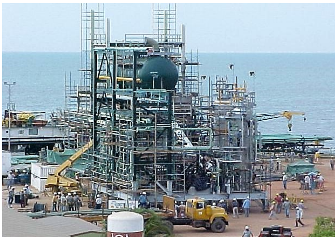
Módulos de procesos para el delayed coker de Hovensa en St Croix. Hechos en Venezuela
