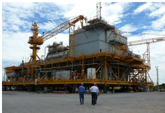
Plataforma en construcción
