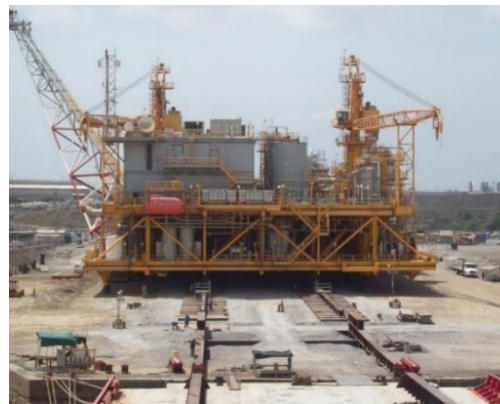
Desplazamiento de la plataforma con todos los equipos hacia el Orinoco
