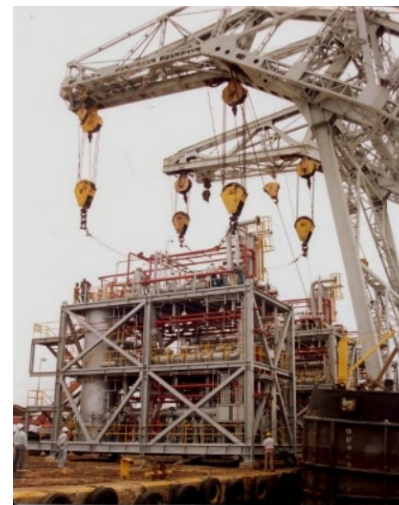
Módulos de procesos para el delayed coker de Hovensa en St Croix. Hechos en Venezuela
