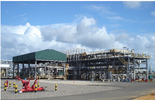
Faja, unidad de producción, diseñada y construida por empresa venezolana
