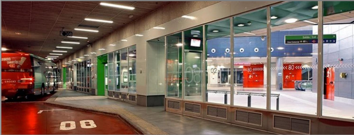
Imagen N° 15. Dársenas interiores del Intercambiador Av. América
