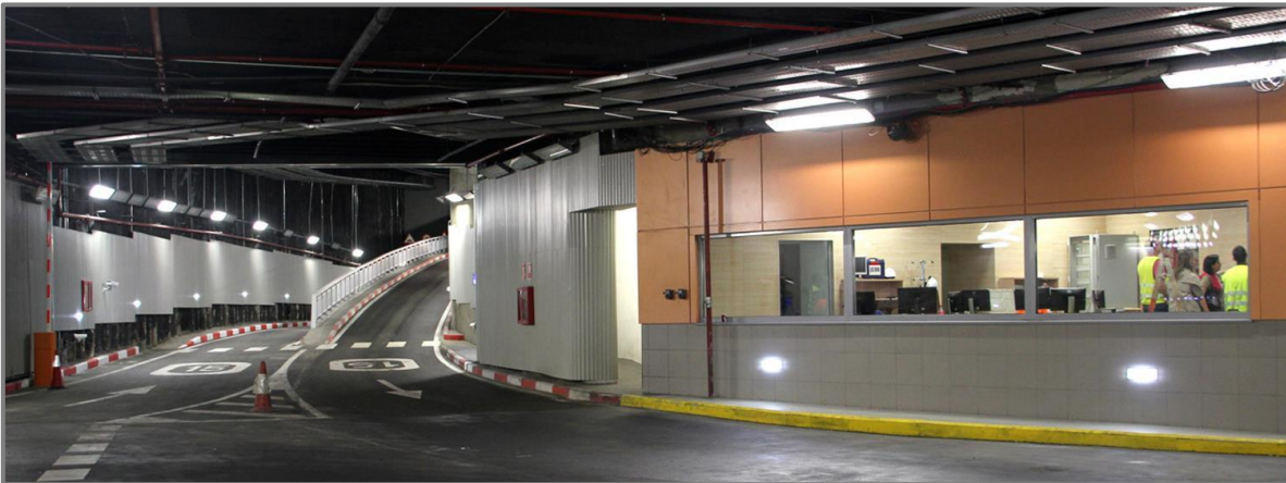
Imagen N° 16. Vías de acceso vehicular del Intercambiador Av. América
