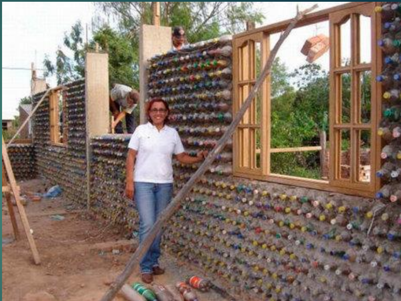
CONSTRUCCIÓN DE PAREDES CON BOTELLAS DE PLÁSTICO RECICLADAS
